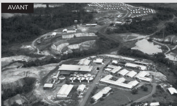
Usine de traitement du site minier de Mounana, Gabon
