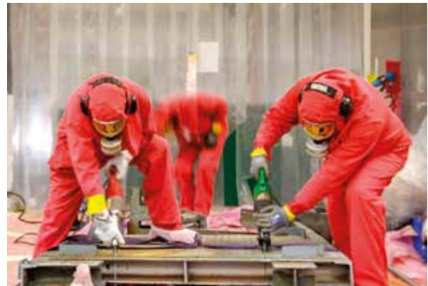
Opérations de démantèlement de l'atelier TE (Orano Tricastin).
