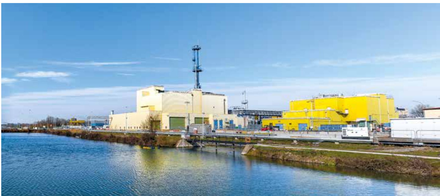
Atelier TU5, mis en service en 1996.
