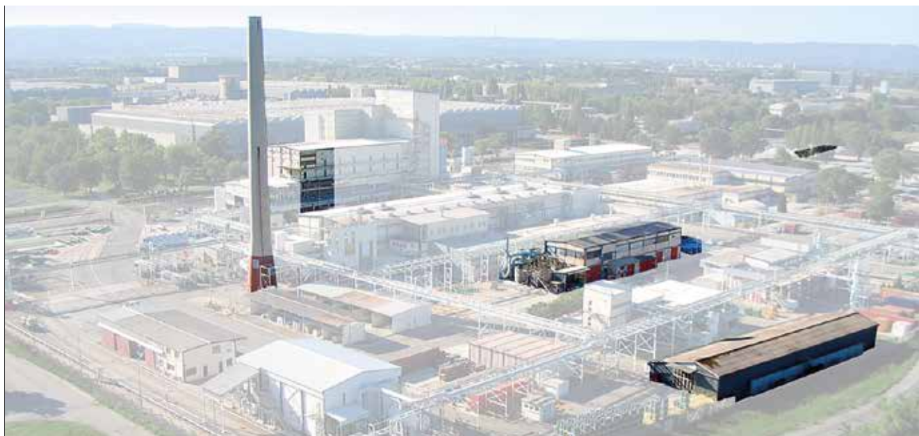
Installations de l'INB 105 en attente de démantèlement.
