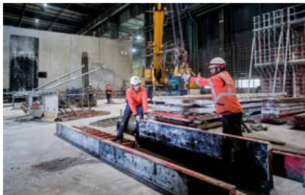
L'atelier TRIDENT, actuellement en phase chantier, permettra de traiter 2500 tonnes de déchets par an.
