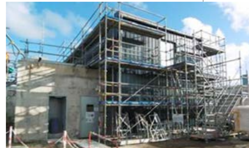
Photo 9 : travaux de génie civil en toit de Silos
