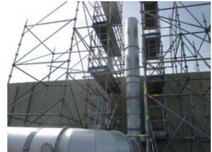
Photo 7 : montage de la cheminée en toit de silo
