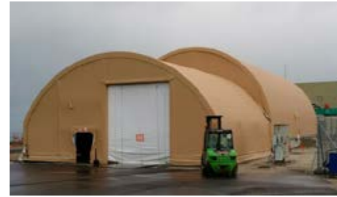
Photo 4 : mise hors d'eau hors d'air du nouveau bâtiment
