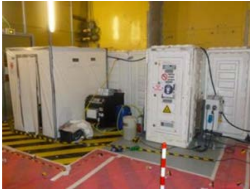
Photo 10 : travaux de désamiantage de l'atelier STE3 (INB 118)
