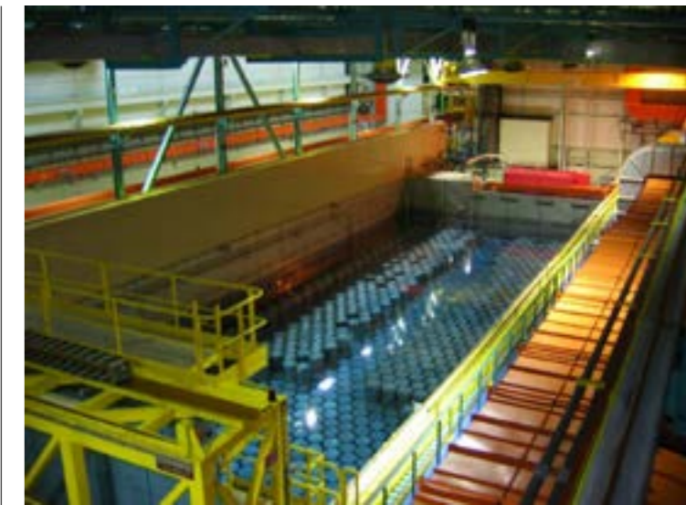
Photo 2 : piscine du SOC
