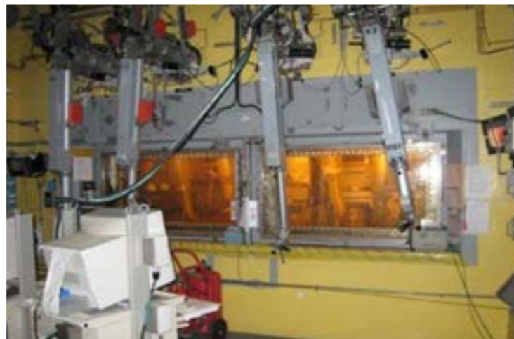
Photo 12 : traitement des fûts dans l'UCD
