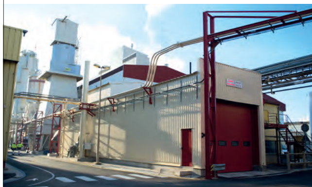
Station confinée de dépotage de l'acide fluorhydrique
