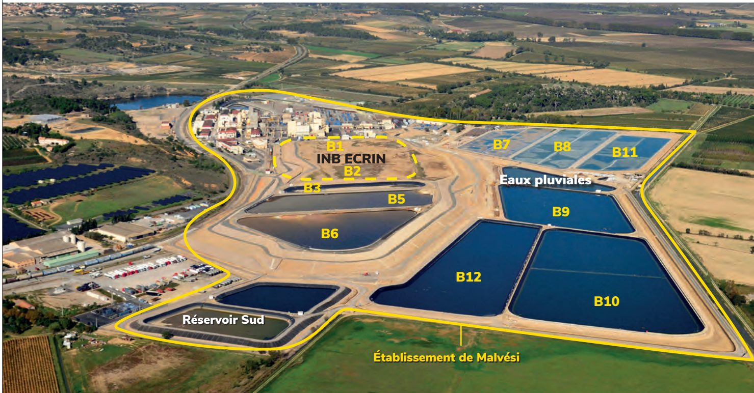
Vue des bassins du site de Malvési
