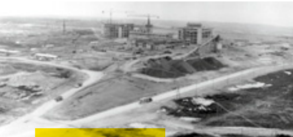
Construction de l'usine UP2-400 en 1963.
