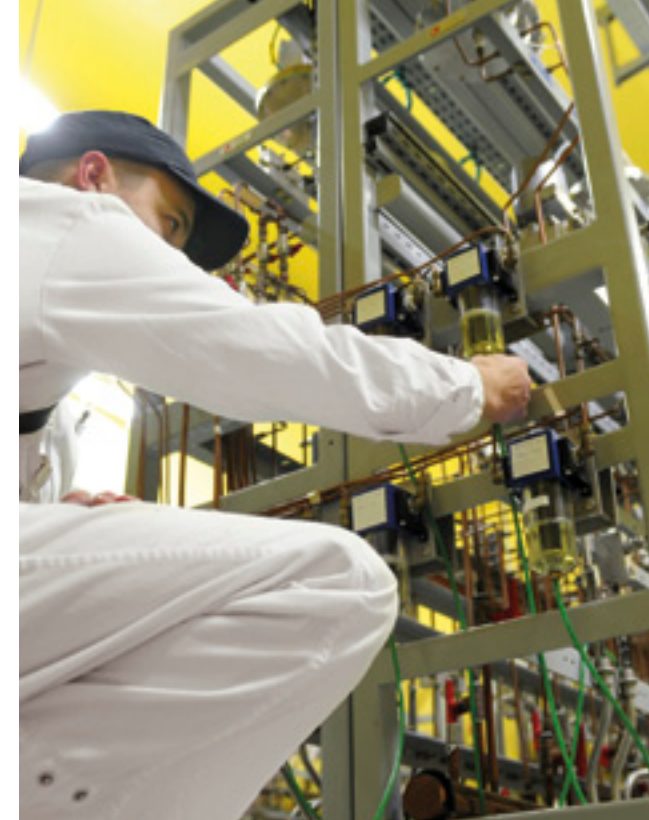
Opération de maintenance réalisée sur l'usine UP3.
