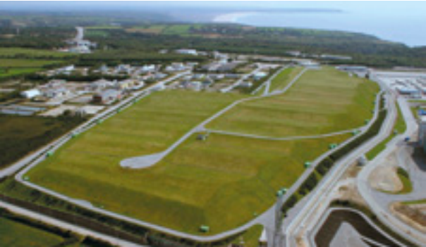
Vue aérienne du centre ANDRA de stockage de la Manche.
