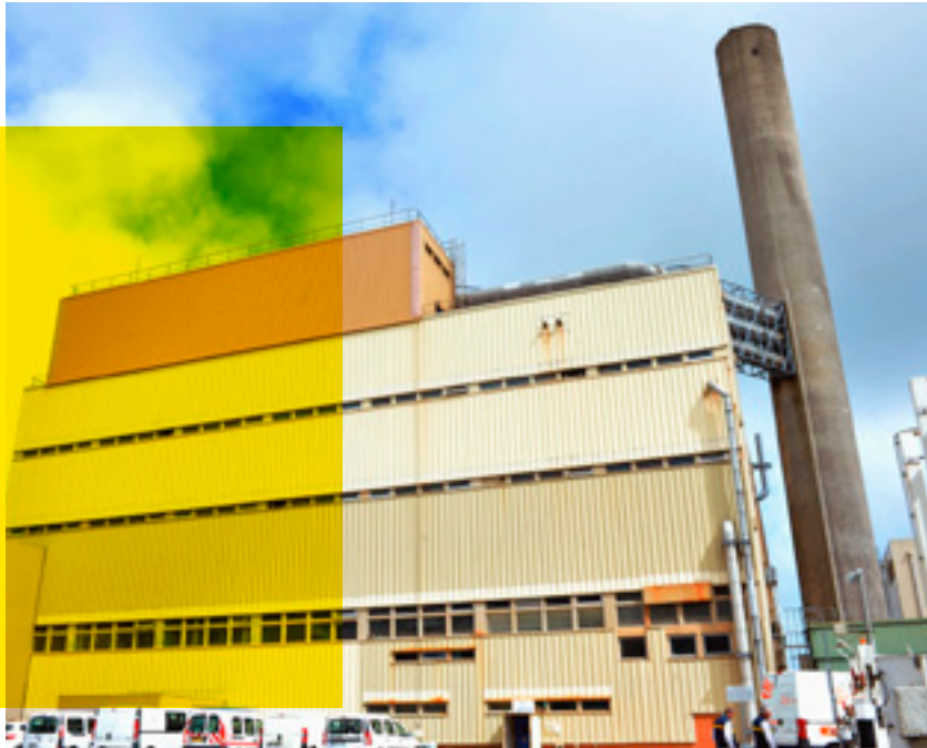
La Centrale de Production de Calories (CPC).
