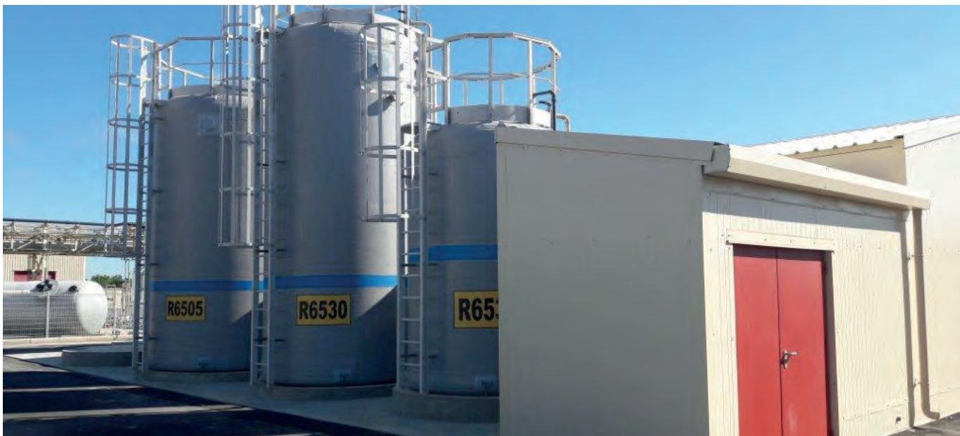
Atelier de préparation de l'eau industrielle
