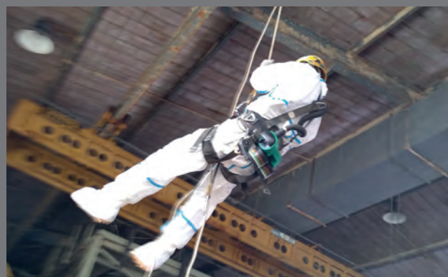
Sécurisation de la toiture du bâtiment magnésiothermie avant démantèlement par des cordistes
