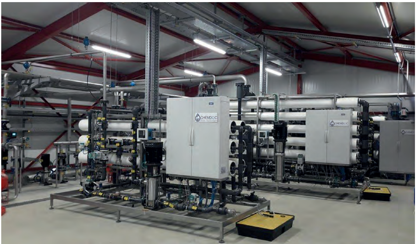
Équipement d'osmose inverse pour la préparation de l'eau industrielle
