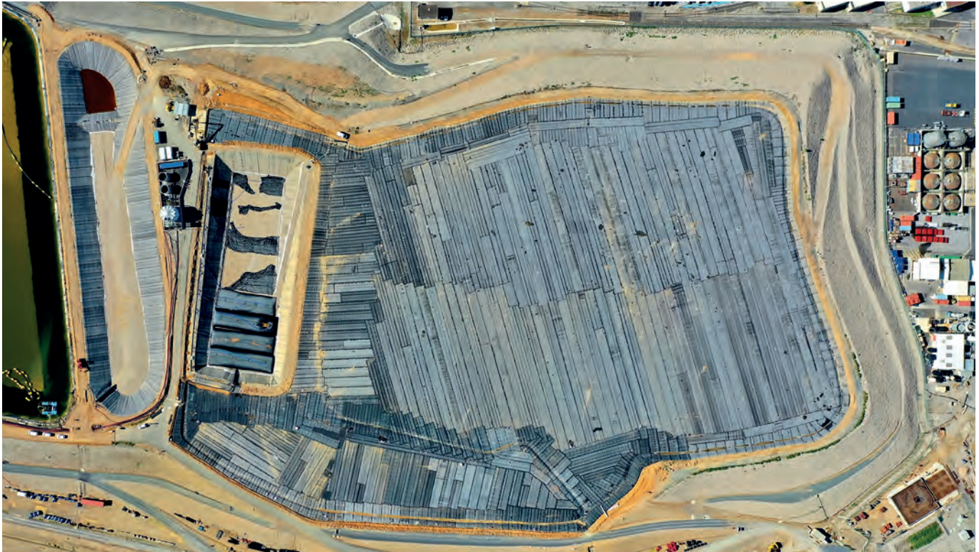
Vue aérienne de la couverture bitumeuse de l'INB ECRIN
